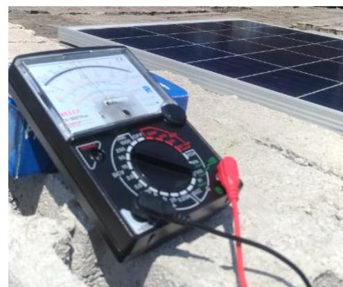
Gambar 5. Pengujian Panel Surya
